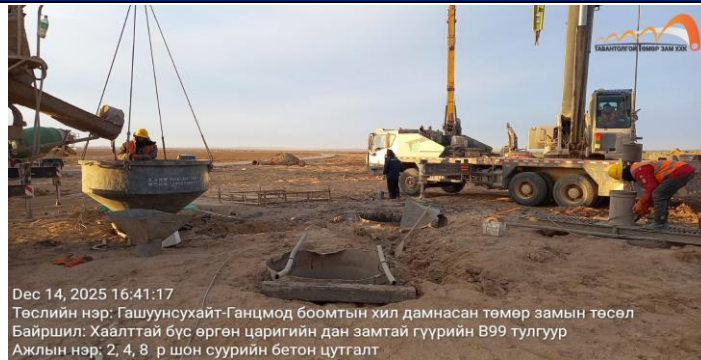
Гүүрийн B99 тулгуурын 2, 4, 8-р шон суурийн бетон цутгалтын ажил
