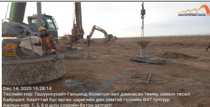
Гүүрийн B47 тулгуурын 1, 5, 6-р шон суурийн бетон цутгалт
