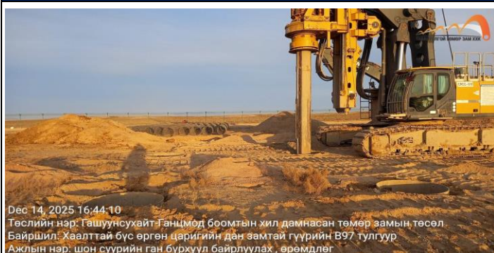
Гүүрийн B97 тулгуурын шон суурийн ган бүрхүүл байрлуулах, өрөмдлөг
