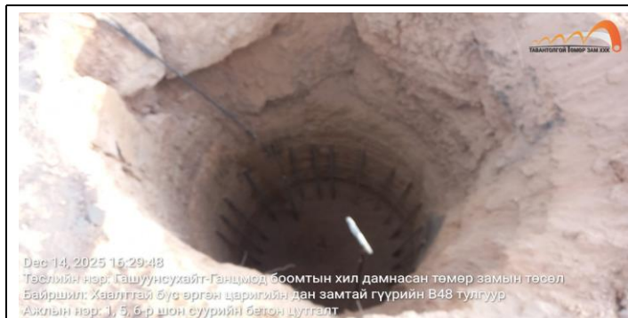
Гүүрийн В48 тулгуурын 5, 6-р шон суурийн арматурчлал байрлуулан, бетон цутгах
