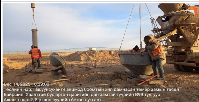
Гүүрийн B99 тулгуурын 2, 8-р шон суурийн бетон цутгалт
